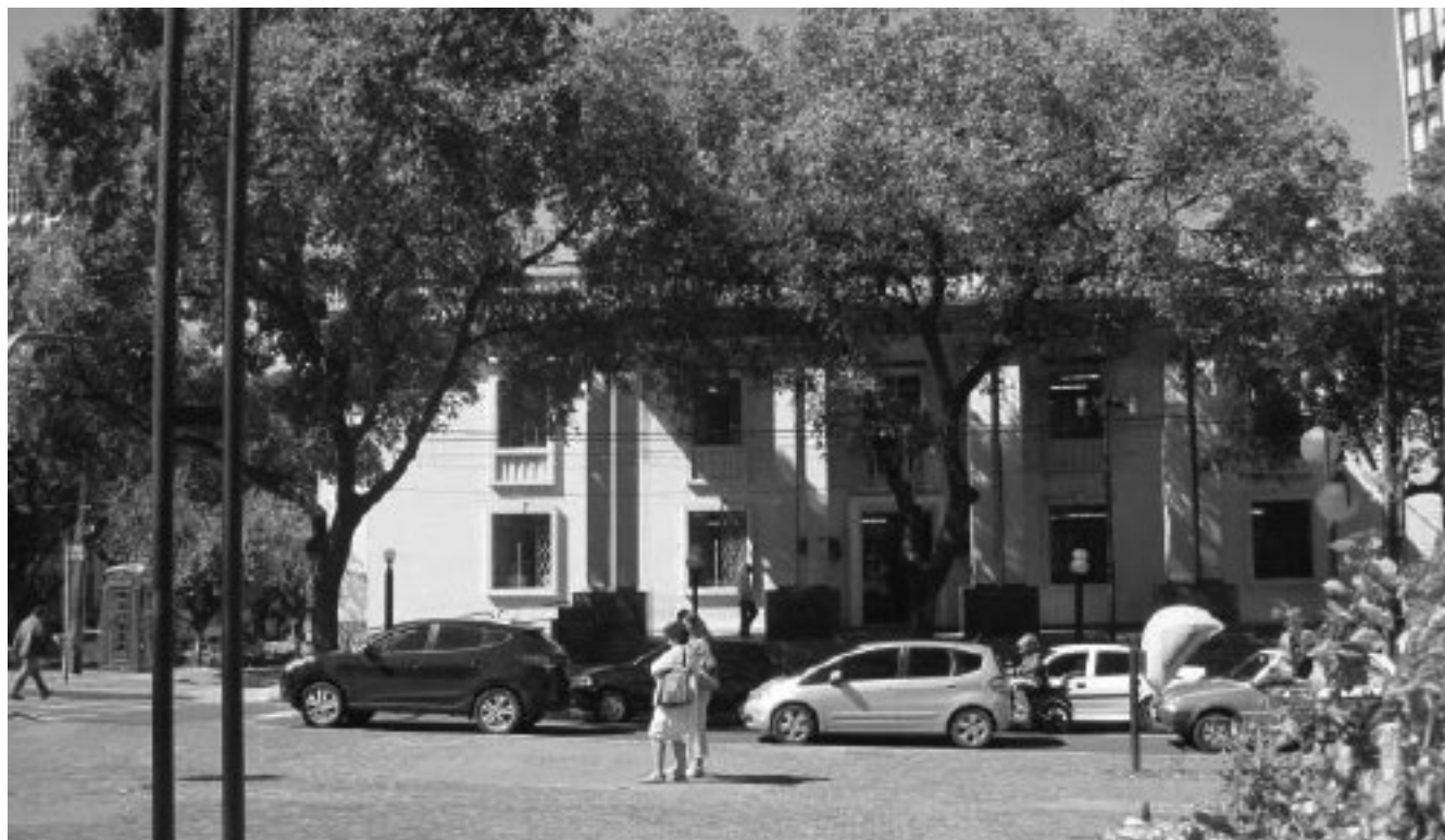
FIGURA 5 Edificio de la Biblioteca Pública Municipal
